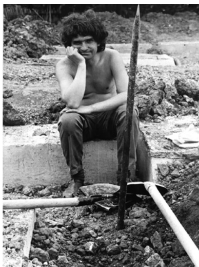
На стройке ИБМ. 1984 г.
